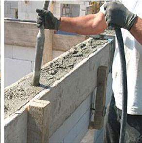
Die Mauern bestehen aus rustikalen hell-beigen Naturziegeln und werden durch eine Polyethylen-Membran gegen aufsteigende Feuchtigkeit geschützt. Zur Stabilisierung des Mauerwerks (selbst bei unseren kuscheligen Mini-Häusern) werden durchlaufende Ring-Armierungen (sogenannte 'Ringanker') und Betonsäulen eingearbeitet.
